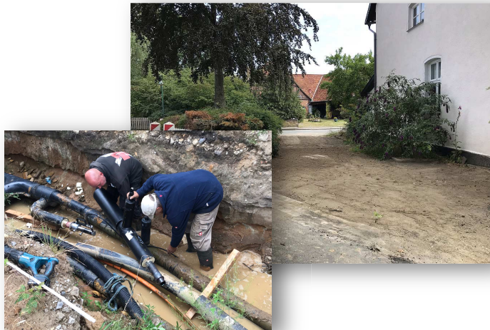
Horst und Thilo montieren den Schieber | Die Grube ist wieder verschlossen
